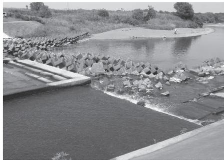
菅間の堰の上流側。永年の洗堀によって右岸側にもエプロンの下端に70cm程の落差ができています。
