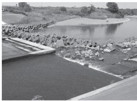
菅間の堰の上流側。永年の洗堀によって右岸側にもエプロンの下端に70cm程の落差ができている。
