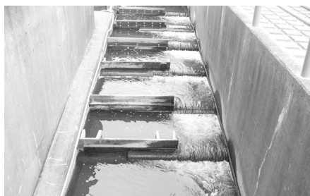
改修後の魚道。アイスハーバー魚道化して遡上し易いように改修されている
