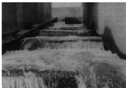
改修前の階段式「魚道」の状態。魚には極めて厳しい遡上環境だったことが分かる。
