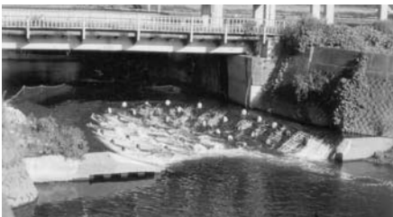
横浜市鵜川の粗石付双斜曲面式(全断面魚道)
