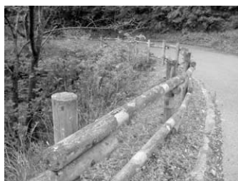
間伐材を利用したガードレール例
