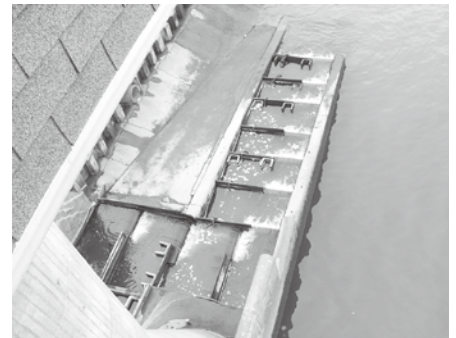
秋ヶ瀬取水堰にある魚道。出べそ状の古い魚道だが、近年アユの遡上数は増えている。
