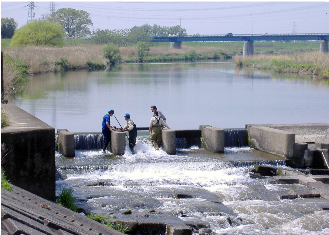
標識アユ放流に向けて入間川の川越市にある寺山堰の堰板を上げる(4月19日) 写真撮影・荒川流域ネットワーク
