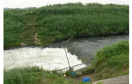
武蔵水路の荒川との合流点
