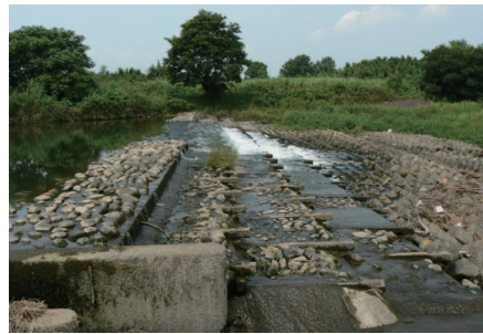
越辺川の株木堰。中央部が階段状に落ちているらった。
