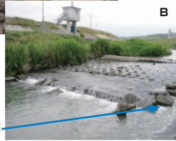
部分的に落差を解消
