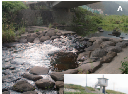
休憩プールを作り、高い落差に対応した例
